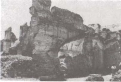
La utilización de tapiales en la construcción colonial, Convento Franciscano del Siglo XVI, Antigua, Guatemala.
