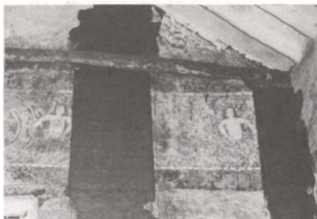
Lamentable intervención reciente para reparar fisuras en el muro de adobe sin respetar la pintura. A la derecha se ven los daños en la pintura al reparar la cubierta.
