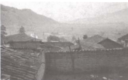
Construcción de adobe, como arquitectura vernácula en una población del Altiplano, San Andrés Xecúl, Totonicapán.
