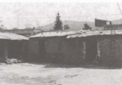
Figura 10. Casa con establo. Gpe. Victoria, Ecatepec.
