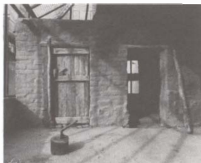
FIG. 20 Façade de l'îlot nord reconstitué. Parement revêtu d'un enduit de terre argileuse. Photo G. Xuereb (Martigues Communication).
