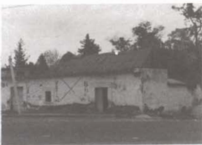
Figura 12. Construcción a dos aguas con lamina Galvanizada, C. 1900. Tlalmanalco, Edo. de México.
