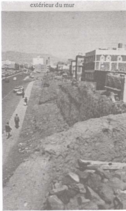
extérieur du mur
