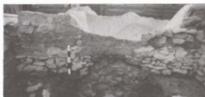
FIG. 8 Bouchage d'une porte selon la technique de la bauge (IIIe s. av. J.C.) Photo J.C -L.
