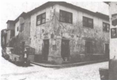
Construcción de dos niveles en el sistema de Bahareque, Santo Tomás Chichicastenango.
