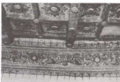
Detalle de la pintura mural restaurada cuidadosamente diferenciando las partes reintegradas de las originales. La restauración, con asistencia de la UNESCO, concluyó en 1978.
