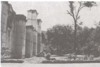
También en la Construcción de la Recolección, así como en muchas otras, muros de más de 17 vrs. de alto, con Tapial.
