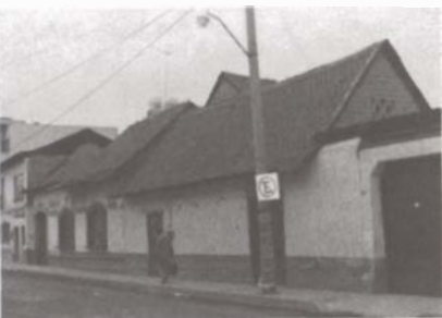
Figura 14. Construcciones a dos aguas con teja plana, C 1900; Amecameca, Edo. de México.
