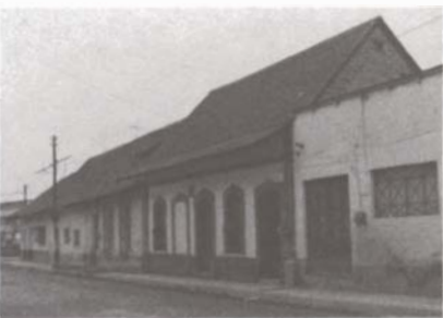
Figura 13. Construcciones a dos aguas con teja plana, C 1900; Amecameca, Edo. de México.
