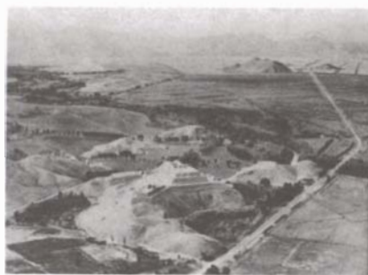
Fortaleza de Paramonga construida con tierra, en la costa peruana, antes de la llegada de los españoles.
