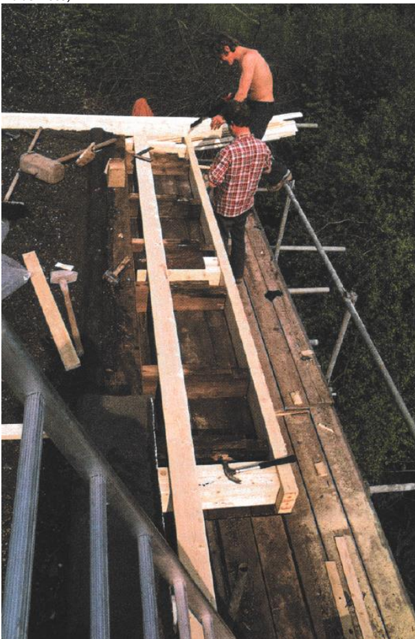
Foto 18 Reparatie dakoverstek oostgevel (Zijl and Mulder 2009)
