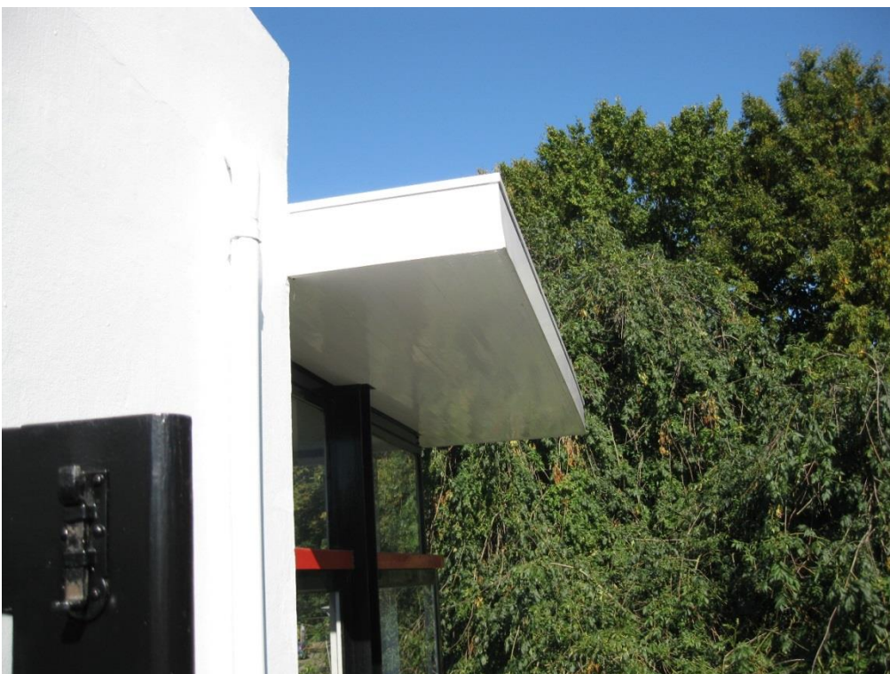
Foto 6 Uitkragende dakluifel noordoostzijde
