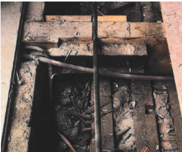
Foto 14 Verbinding van de staalconstructie van het balkon aan de oostgevel met de houten balklaag (Zijl and Mulder 2009)
