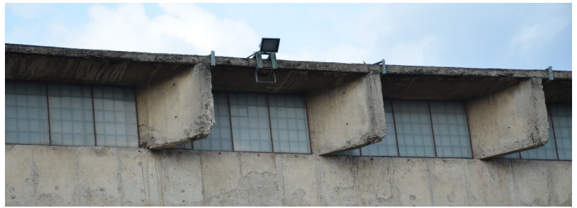
Fig. 32: Brise soleil as fenêtre en longueur along the length of the facade.
