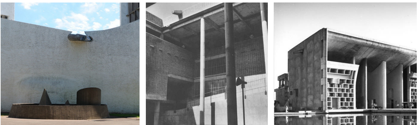
Fig. 75: Concrete gargoyle and splash pool at Chapel of Notre Dame du Haut. Source: https://de.wikipedia.org/wiki/Datei:Notre_Dame_du_Haut_Wasserspeier_und_Becken(ws).jpg (L); Concrete gargoyles at Sanskar Kendra Ahmedabad (C), High Court Chandigarh (R). Source: FLC Archive
