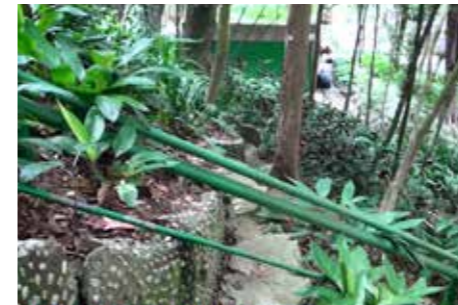
30 mureta em processo de ruptura e caminho interrompido portubulação da rede elétrica, telefonia e lógica.
