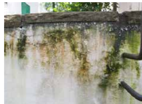
Fungos, manchas, trincas e desprendimento do revestimento e da pintura nas paredes externas.
