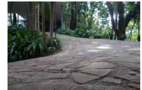
Curvatura da superfície de piso entre os dois lances da rampa.
