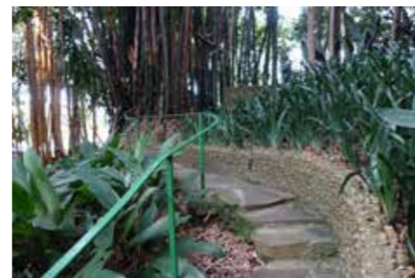
Corrimão acompanhando escada (PA.02.03) e curvatura da mureta de arrimo (PA. 01.03) no caminho do estúdio
