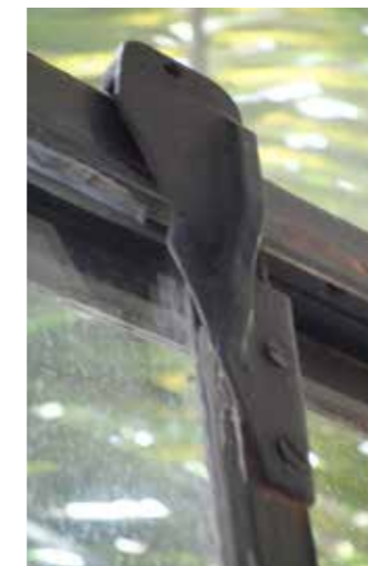
Pino como dispositivo de travamento da abertura.
