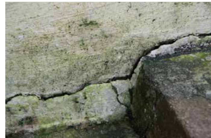
Passeio em concreto nas escadas externas.
