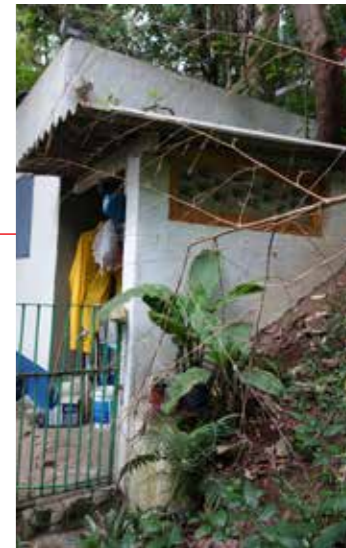
Gárgula sobre a área de serviço
