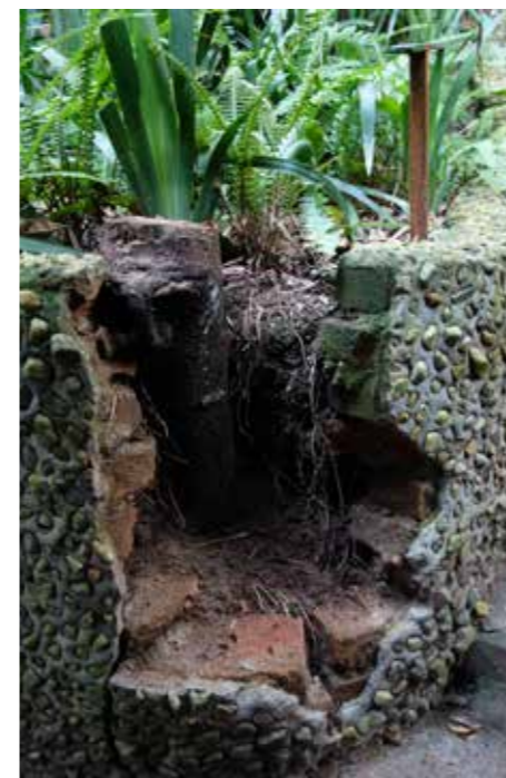
Mureta danificada pela queda da árvore 827, prevista para poda completa.
