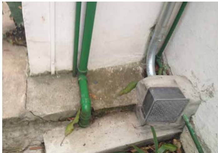
Novo sistema de tubos aéreos e externos, com elétrica, telefonia e rede lógica.
