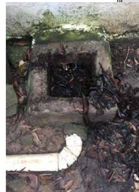
Caixa de inspeção da saída de águas pluviais no pátio jardim. Observar a presença de folhas que escoaram pelo duto.
