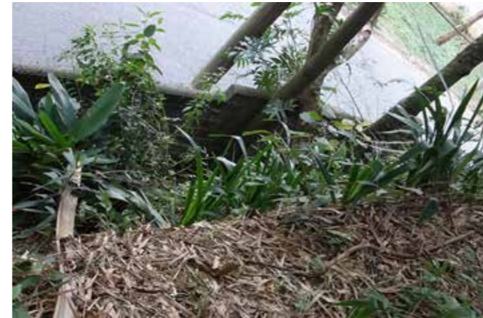
Árvores com interferência no muro de divisa, previsto o corte. Indivíduos 723, 724, 725 .
