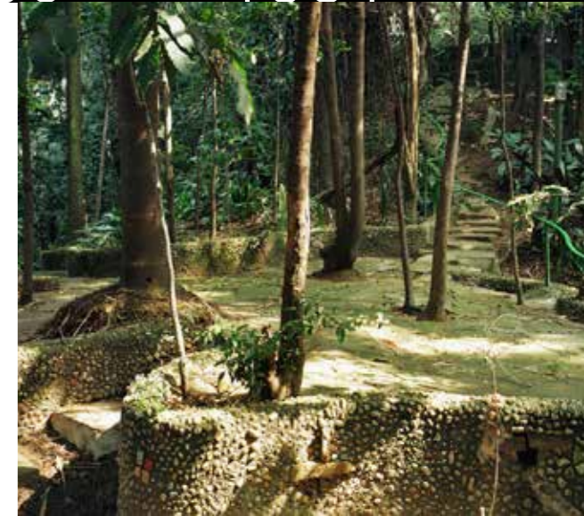
Construídos os corrimãos dos caminhos do jardim, novas cortinas, pinturas e troca de vidros.
