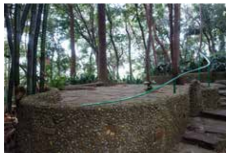
Corrimão acompanhando escada (PA.02.03) e curvatura da mureta de arrimo (PA. 01.03) junto ao piso de estar (PA.02.05).
