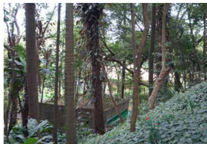
Grande quantidade de vegetação e árvores de pequeno e médio porte sobre a laje impermeabilizada.
