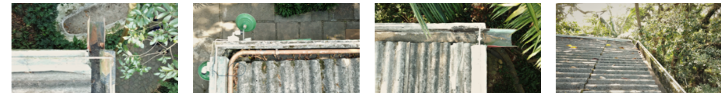
Figura 18. Calhas e rufos das extremidades da Casa de Vidro
