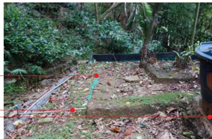
Laje jardim de cobertura. Vista da laje com a cobertura de terra parcialmente removida para manutenção da Impermeabilização.
