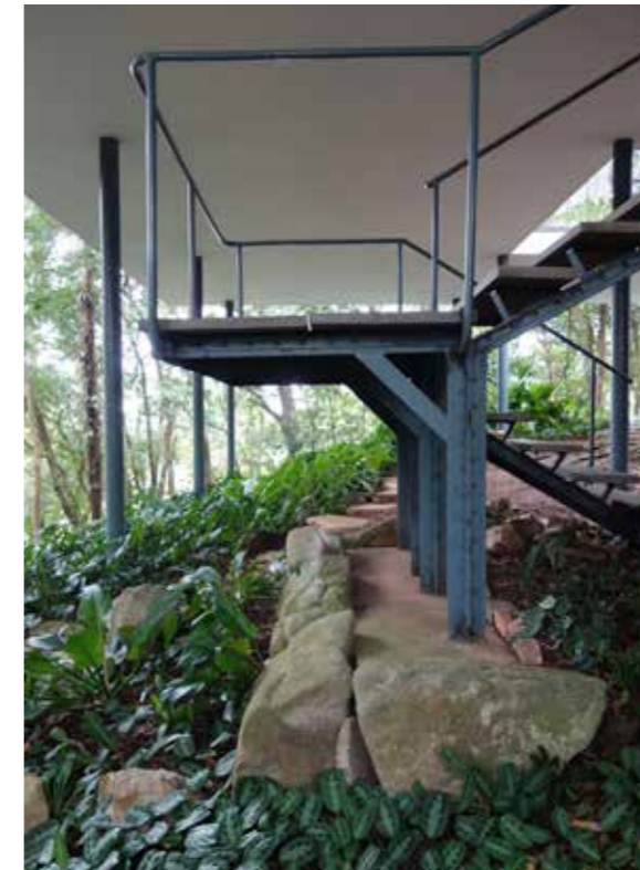
Patamar em granito apoiado na estrutura, com mão francesa
