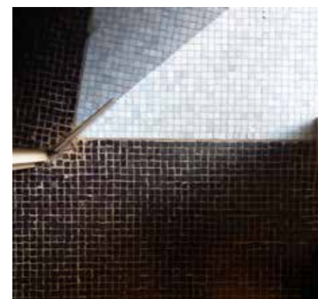
Passagem do piso em pastilha vidrotil de cor azul celeste da sala de estar para o de cor preta na copa
