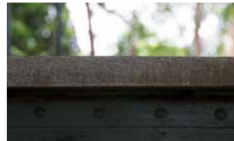
Detalhe dos rebites e placa de granito do patamar
