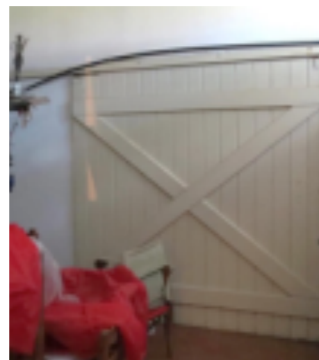
Portas de madeira maciça nas passagens da área de serviço
