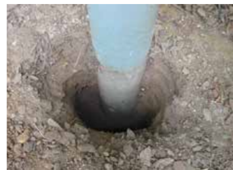
Escavação até a sapata de fundação
