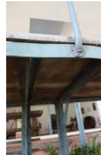
Vista inferior do assentamento do patamar na estrutura
