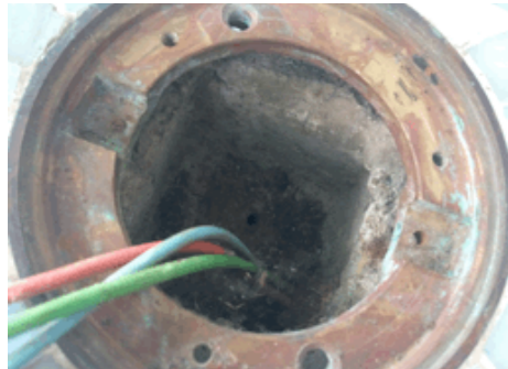
Imagem 7: Detalhe da tomada na laje do piso
