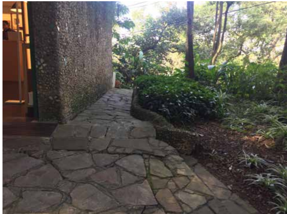
Calçada lateral em arenito rosa, com a canaleta em primeiro plano.
