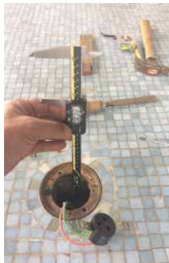
Imagem 9: Medição de espessura da laje
