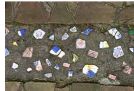
Incrustação de cacos de cerâmica esmaltada colorida entre as duas faixas de rolamento do primeiro lance da rampa.
