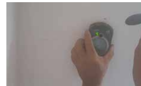
Imagem 11: Extração de minitestemunhos: detecção da armadura com o pacômetro
