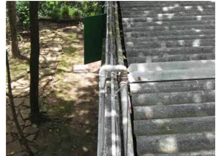
Viga calha de concreto posterior Entrada de tubo de queda de água pluvial embutido. Observe-se a interferência da instalação hidráulica externa.
