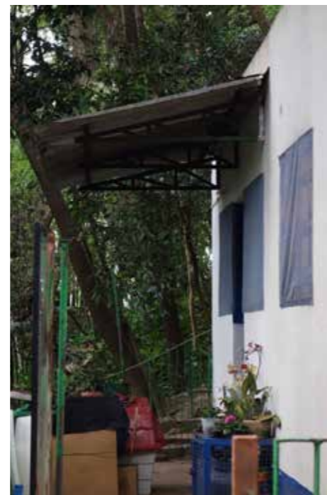
Vista exterior dos caixilho basculantes, com tela mosquiteira e alpendre.
