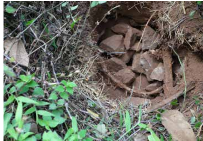
Prospecção na camada de solo e pedra brita que antecede a impermeabilização
