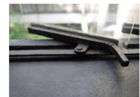
Basculantes do corredor. Detalhe do mecanismo de abertura e fixação do vidro
