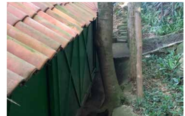
Mureta danificada pela queda da árvore 827, prevista para poda completa.
