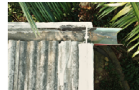
Encaixes das calhas metálicas nas extremidades da calha de concreto frontal
