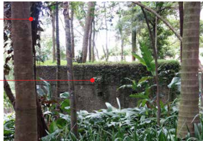
Vista lateral da garagem. Vegetação na laje jardim e revestimento camuflam a construção no jardim
