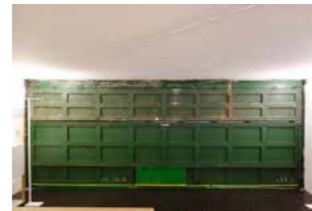
Esquadria portão. Vista interna, portão fechado.
