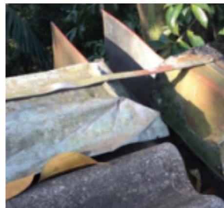
Rufos recobrimo viga platibanda lateral e frontal para proteção.
