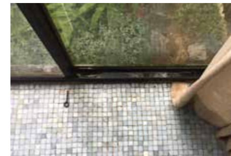
Pino como dispositivo de travamento da abertura.
