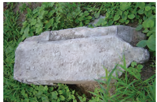
8、宇墙角柱 corner baluster
