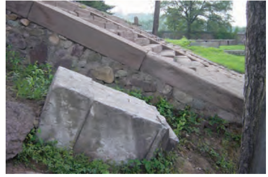
10、宇墙角柱 corner baluster
