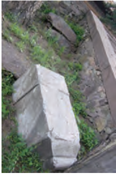
11、宇墙角柱 corner baluster
