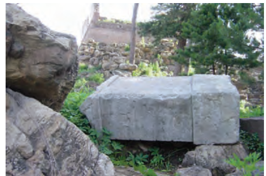
22、宇墙角柱 corner baluster
