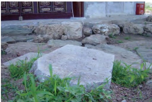
47、台基构件 platform component
