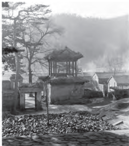
12. 第一进院落西北角腰墙不存之处（1979年） Enclosure wall missing in NW corner of Courtyard 1 (1979, L. von Faulkenhausen)
