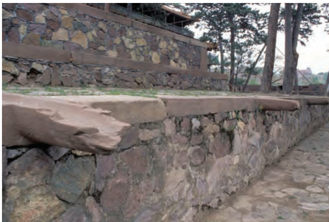
44. 上层月台的排水挑头 Scuppers of Upper Terrace
