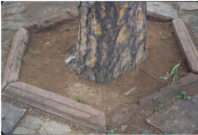
47. 松树树池（红沙石） Sandstone edging stones for pine trees
