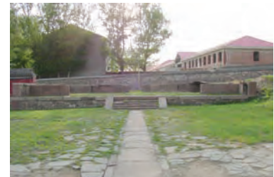
29. 演梵堂（朝西） Yanfan Hall, looking west
