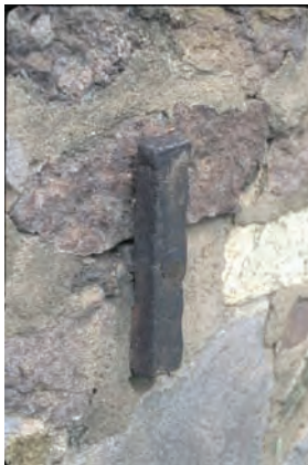
38. 下层月台护坡墙中的铁锚杆 Iron retaining rod, Lower Terrace
