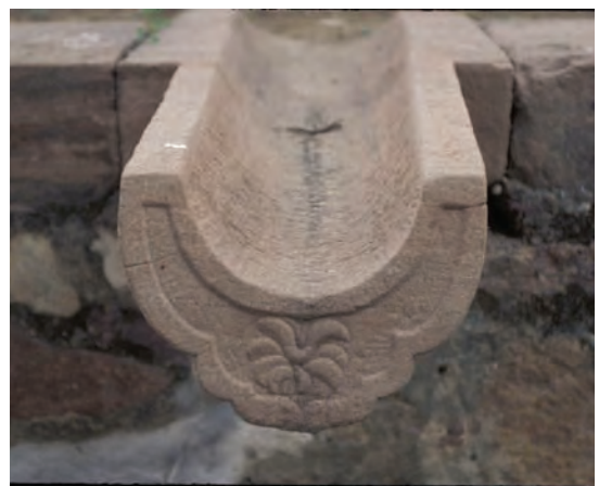
45. 排水挑头的细部 Detail of scupper
