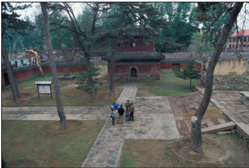
10. 第一进院落全景（朝西），在右边有天王殿台基及石砌坡道 General view of Courtyard 1, looking west
