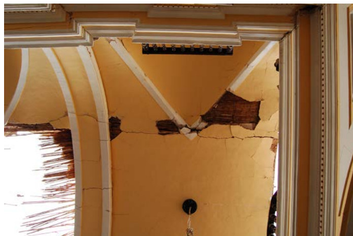
FIGURA 4.14 Vista de la grieta donde ocurrió el colapso parcial de la bóveda de la Catedral de Ica; octubre de 2007.
