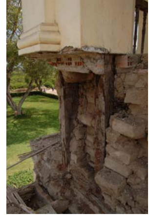
FIGURA 4.39 Detalle de la mezcla de materiales usados en la Hacienda Arona y Montalván; octubre de 2007.
