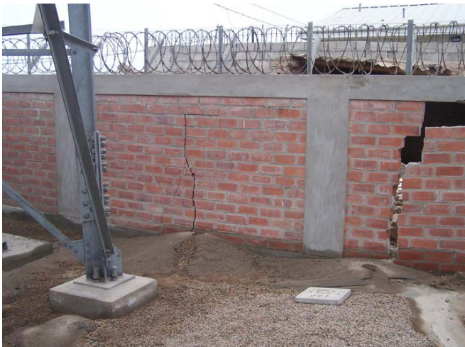
FIGURA 2.18 Licuefacción de un sitio en Tambo de Mora. Imagen: Cortesía de Jorge Alva Hurtado.
