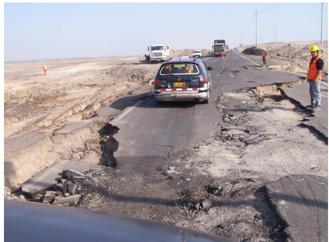
FIGURA 2.19 Efecto de deslizamiento de tierra en la carretera Panamericana.
