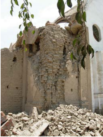
FIGURA 4.37 Detalle de la mezcla de materiales usados en la Iglesia de Coayllo; octubre de 2007.
