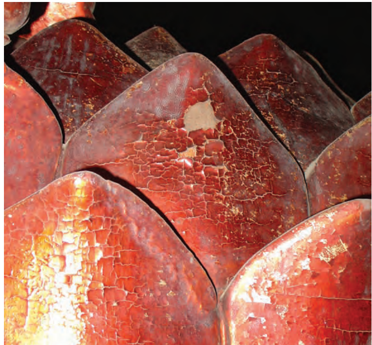
莲花瓣表面和地仗层起甲和脱落。
