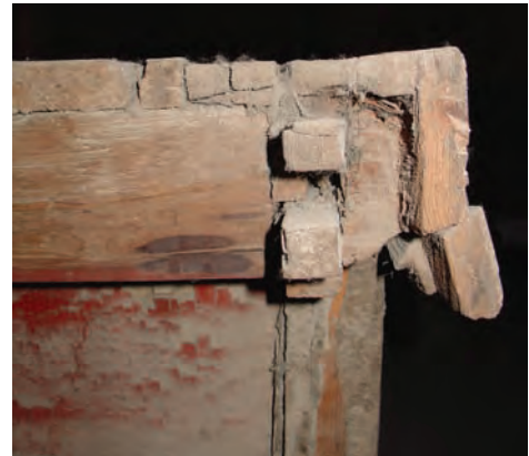
供桌前面部分缺失，曝露出木榫头。
