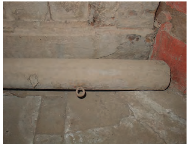
东次间挂杆细节，可见其中一个铁环。挂杆上堆积了厚重的尘土。
