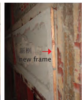
在已更换的经格门边缘可看到加在原经格门上的新框。
