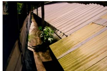
Vista de las Cubiertas.
