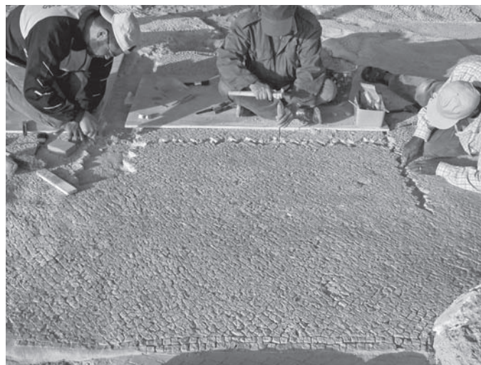
FIGURE 8 Réintégration des saignées après repose de la mosaïque sur site. Photo © ACRM / MAPA.
