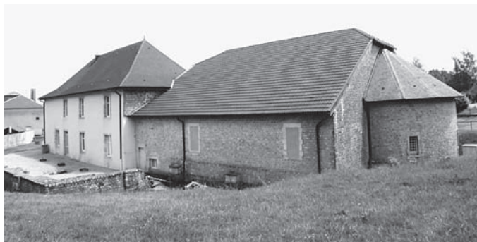
FIGURE 1 Le bâtiment à abside abrite la mosaïque ; l'édifice à deux étages est l'ancien bâtiment des Sœurs, aujourd'hui espace d'accueil pour le public. Photo © ACRM / MAPA.
