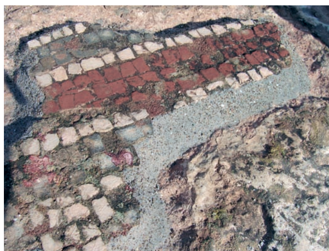
FIGURE 7 Renforcement des parois. Photo © Musée de Tipasa.
