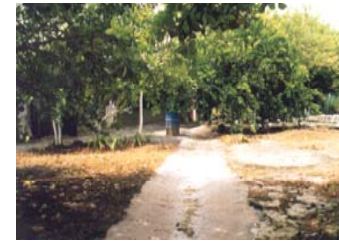
Canaletas de drenaje.
