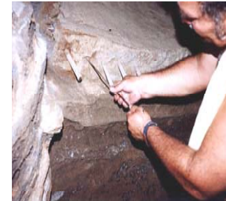
Sustitución de varas en paredes de bajareque.
