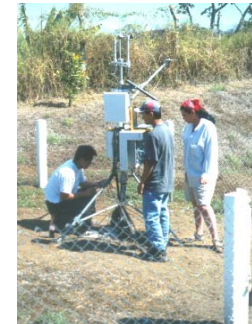
Estación de monitoreo.
