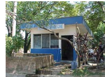
Caseta de seguridad.
