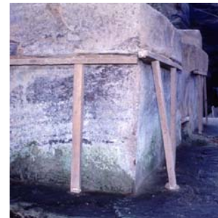
Apuntalamiento de cornisa.
