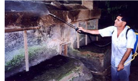
Aplicación por aspersion del mucílago de escobilla.
