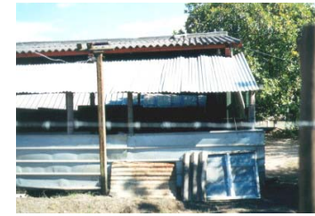
Reparación de cubiertas.
