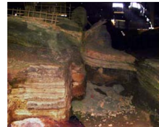
Desprendimiento ocasionado por la acción del sismo.
